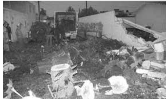
Imagen de los daños causados por el fenómeno meteorológico registrado el domingo 16 de este mes, en gran parte de la entidad ■ Alejandro Ancona
