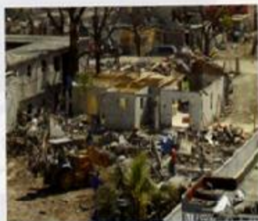
Figura 10. Viviendas dañadas por el tornado de Piedras Negras, 2007.
