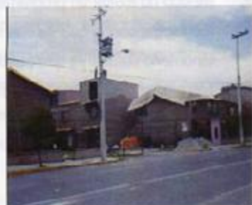
Figura 8. Viviendas dañadas por el tornado de Coacalco, EdoMex.
